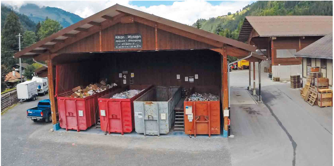
▲ Moderne Entsorgungsanlage an der Matten
